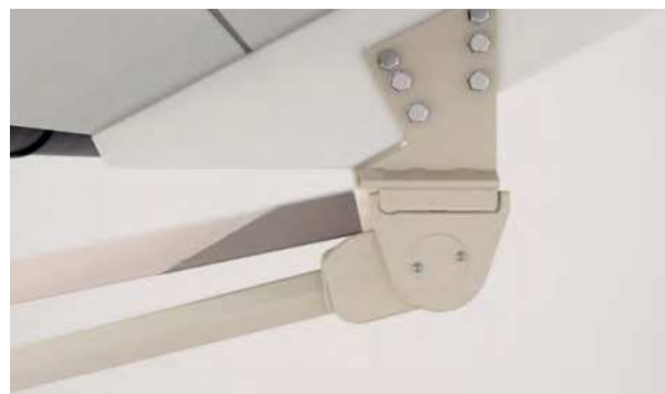
Fijación de vigas
